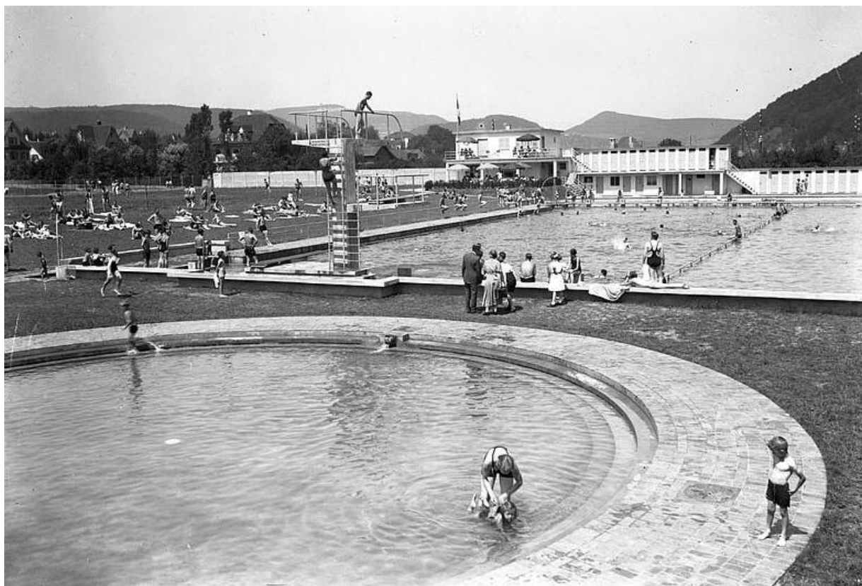
Undatiertes Foto vom Gartenbad Gitterli, vermutlich Ende der 1930er Jahre. Im Vordergrund das alte Kinderbecken, dahinter das weiterhin bestehende Schwimmer- und Nichtschwimmerbecken mit dem ursprünglichen Sprungturm.
