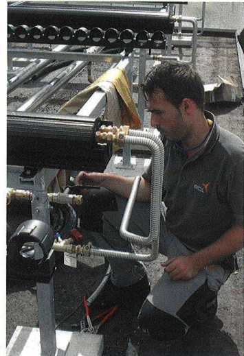
Montage der Hydraulik der thermischen Solaranlage. Die schwarzen Teile werden später die Röhrenkollektoren aufnehmen, die die Wärme produzieren.
